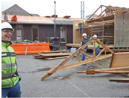
Start Abbau am 18.3.13 unter Leitung von Werni Wigger
